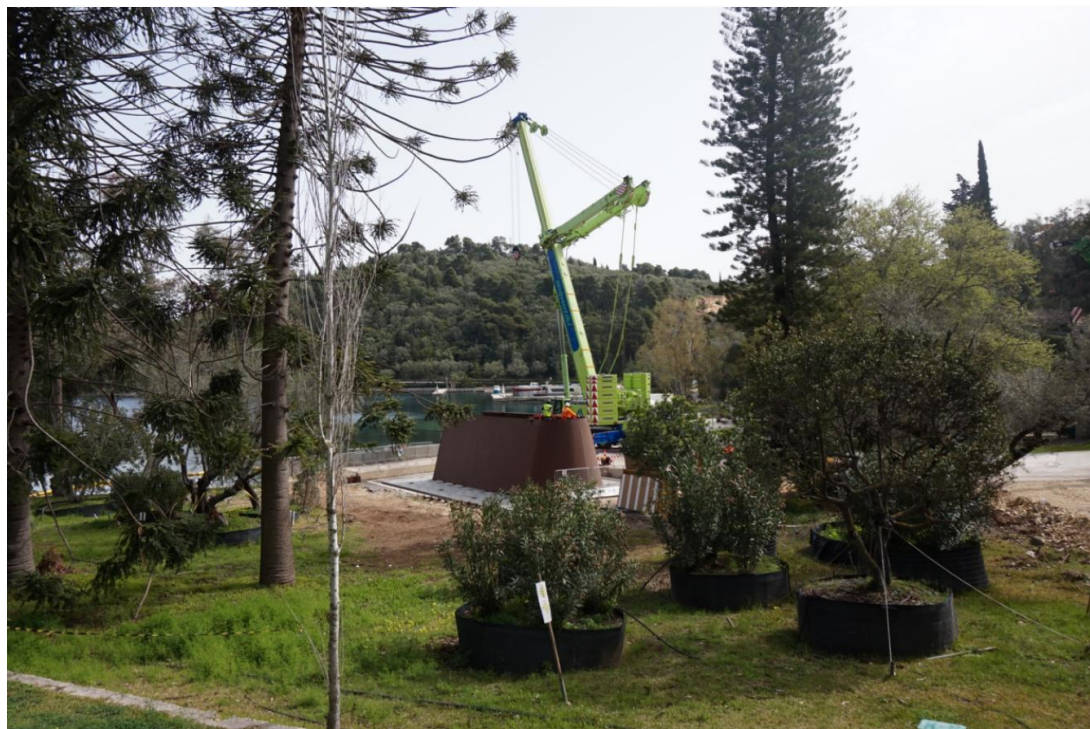
Σχήμα 2.2-2: Διατήρηση και μεταφύτευση της τοπικής χλωρίδας
