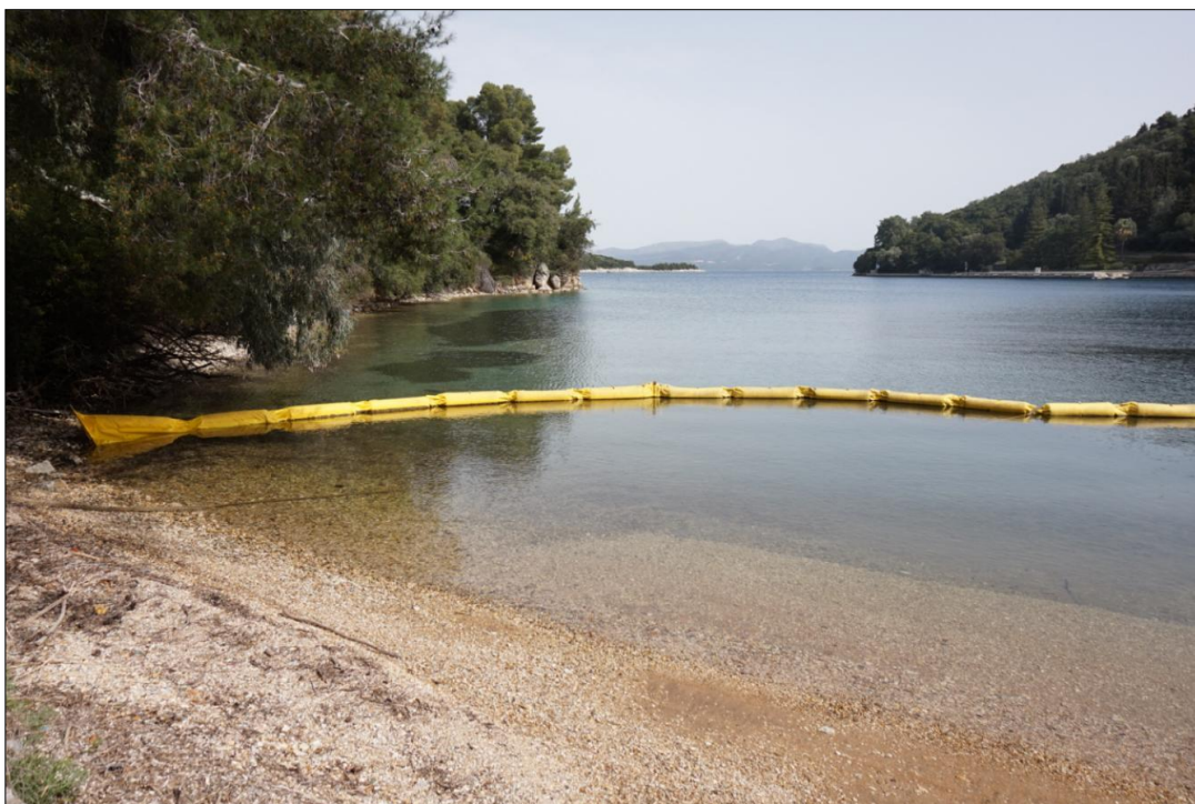
Σχήμα 2.3-1: για τη συγκράτηση λάσπης για προστασία κοντά σε παράκτιο εργοτάξιο.
