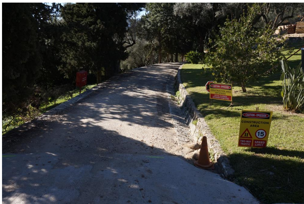
Σχήμα 2.1-5: Όριο ταχύτητας έως 15 km/h σε μη ασφαλτοστρωμένους δρόμους ή δρόμους σε κακή κατάσταση.
