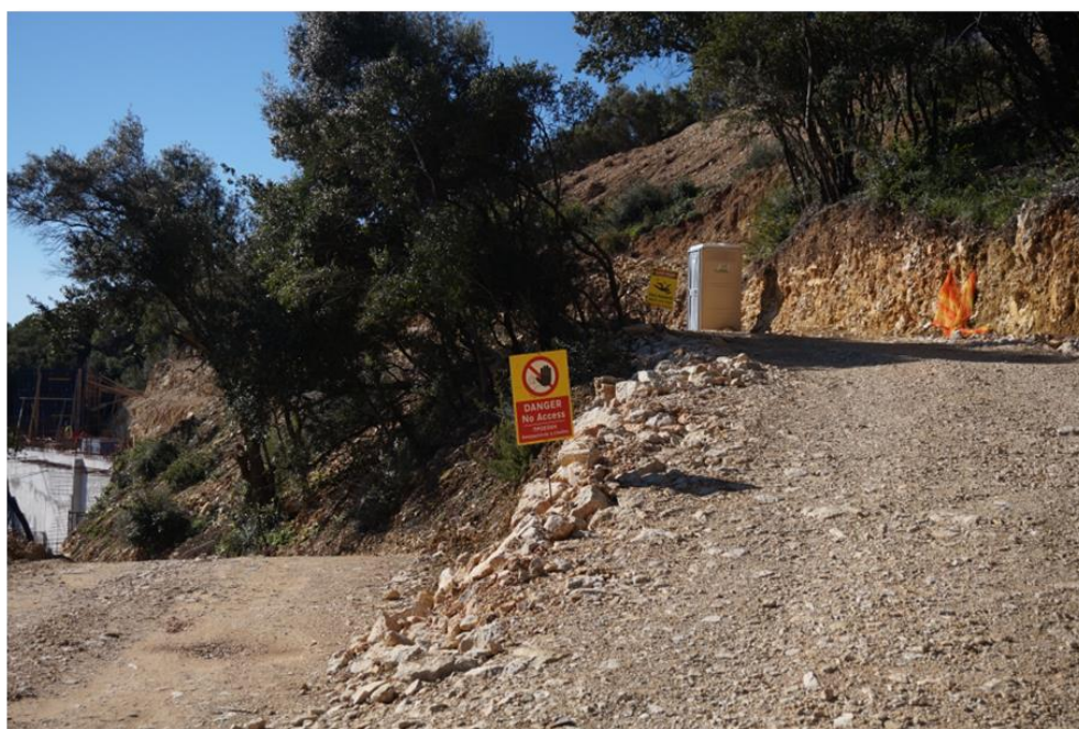
Σχήμα 2.1-10. Σε όλα τα εργοτάξια τοποθετούνται προειδοποιητικές πινακίδες για πιθανούς κινδύνους.
