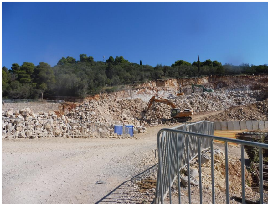
Σχήμα 2.1-8. Εργοτάξια με κατάλληλη περίφραξη και χημικές τουαλέτες.
