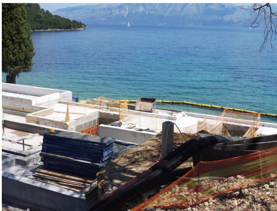
Σχήμα 2.1-9. Σήμανση των χώρων εργασίας του έργου με κατάλληλες περιφράξεις.
