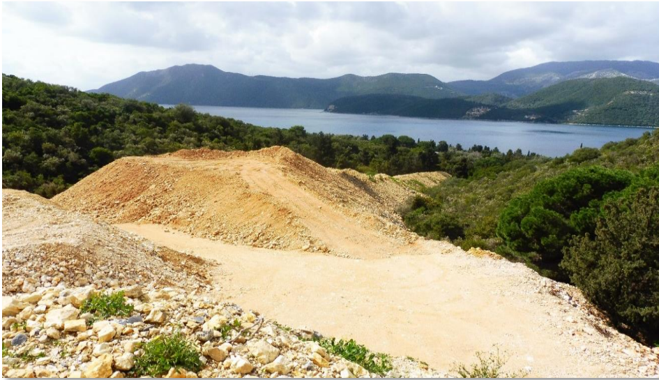
Σχήμα 2.1.3-2. Άποψη από το εργοτάξιο του αποτεφρωτήρα.
