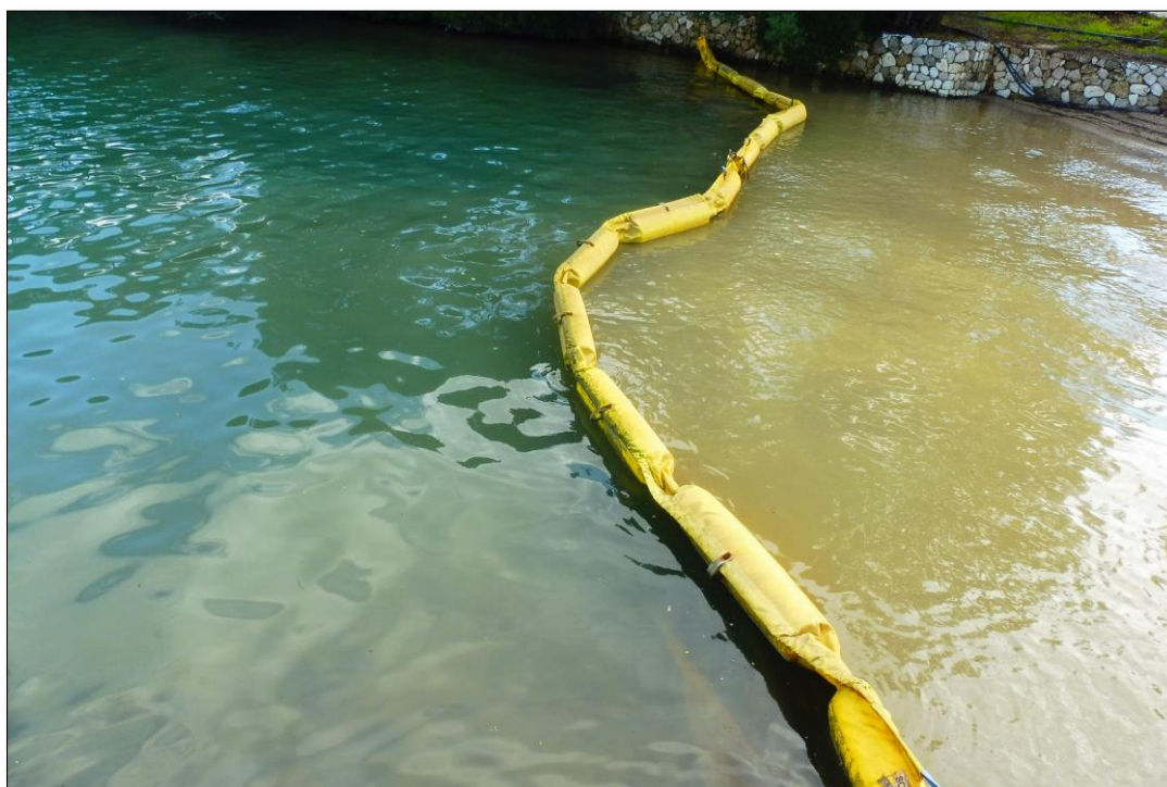
Σχήμα 2.3-1: Κουρτίνα ιλύος για τη συγκράτηση λάσπης και φερτών υλικών για προστασία κοντά σε παράκτιο εργοτάξιο.
