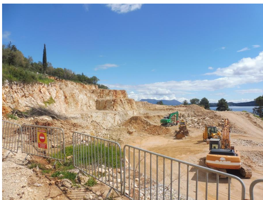
Σχήμα 2.1.3-1. Σήμανση των χώρων εργασίας του έργου με κατάλληλες περιφράξεις και προειδοποιητικές πινακίδες.
